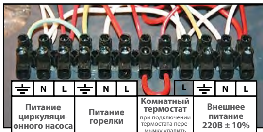
Клеммная колодка в пульте управления котлом
